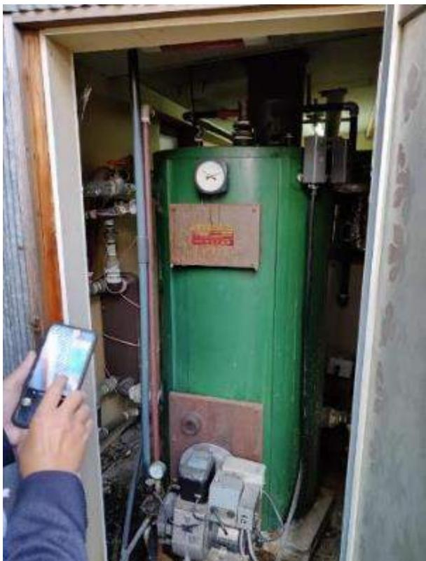
温泉ボイラー燃料を地域産木質バイオマスに切り替え、配管を高断熱化する検討
